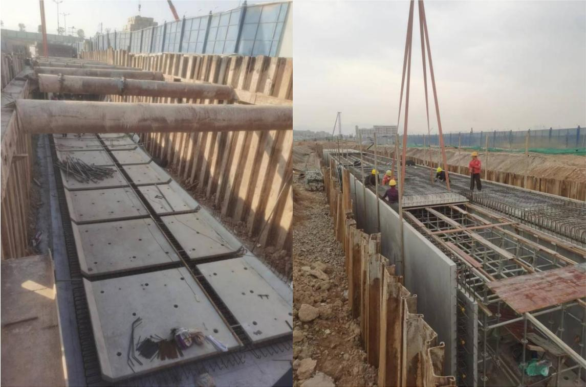
图6 预制叠合构件吊装现场
