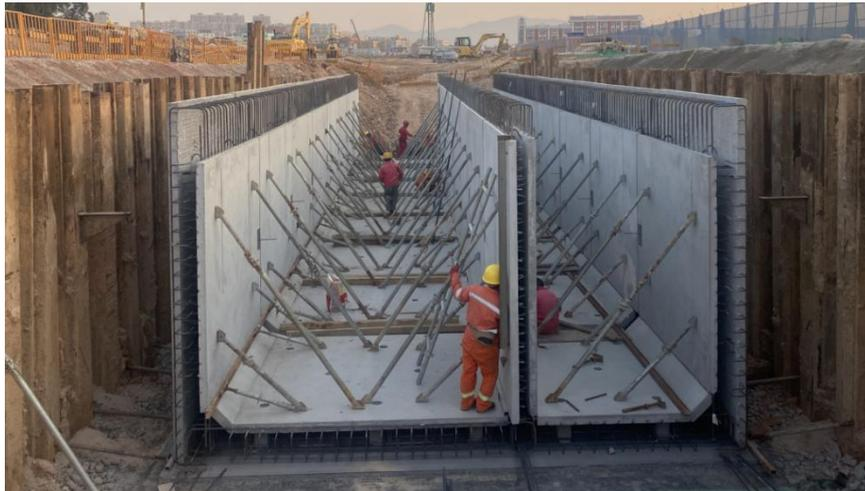
图8 叠合式侧墙安装
