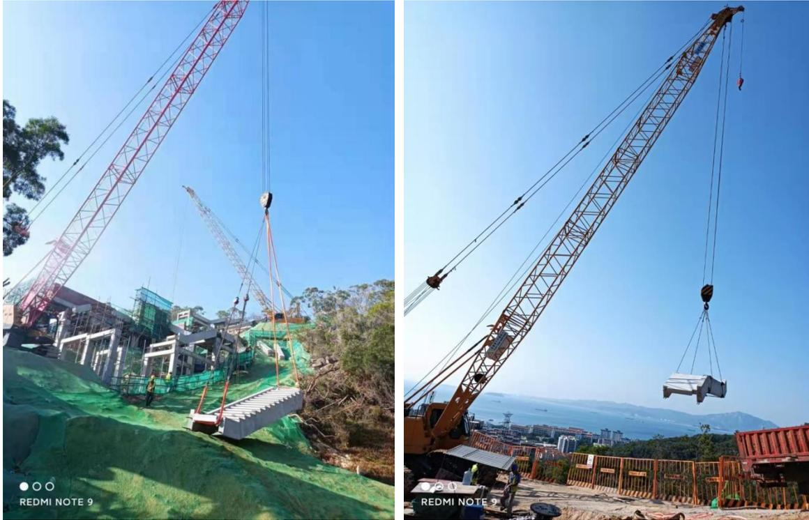
图 5 台阶步道预制构件吊装
