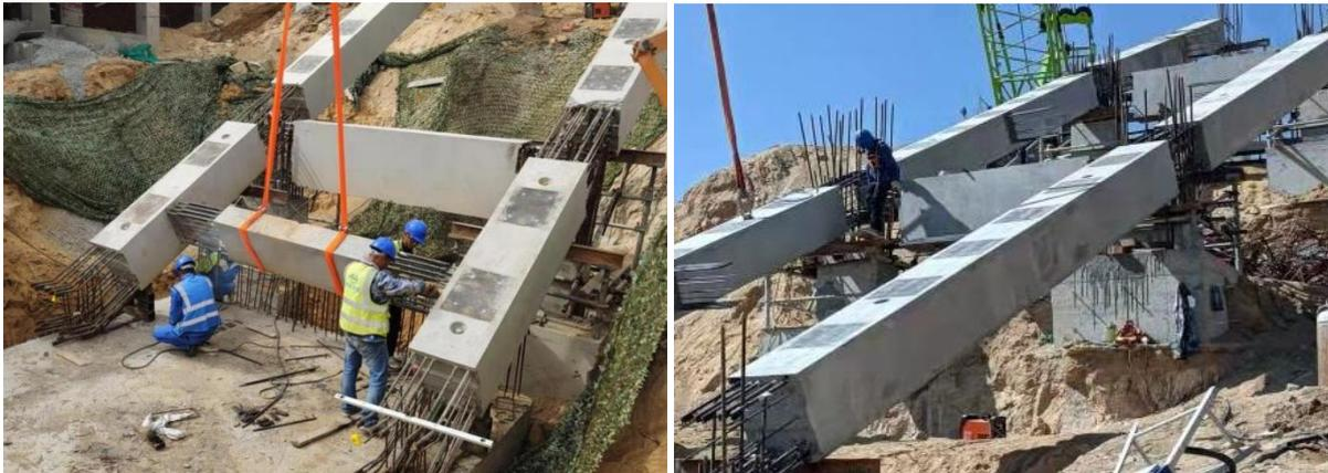
图 6 扶梯预制构件吊装
