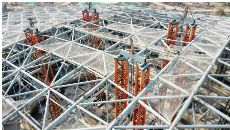
图 20 钢屋盖场芯提升就位
