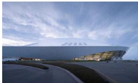
图 7 体育馆幕墙安装完成实景图
