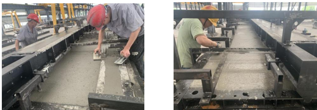
图 12 混凝土浇筑实景图
