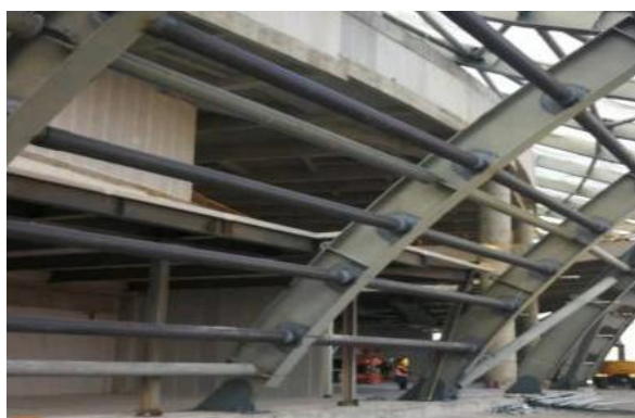
图 26 幕墙龙骨现场安装图
