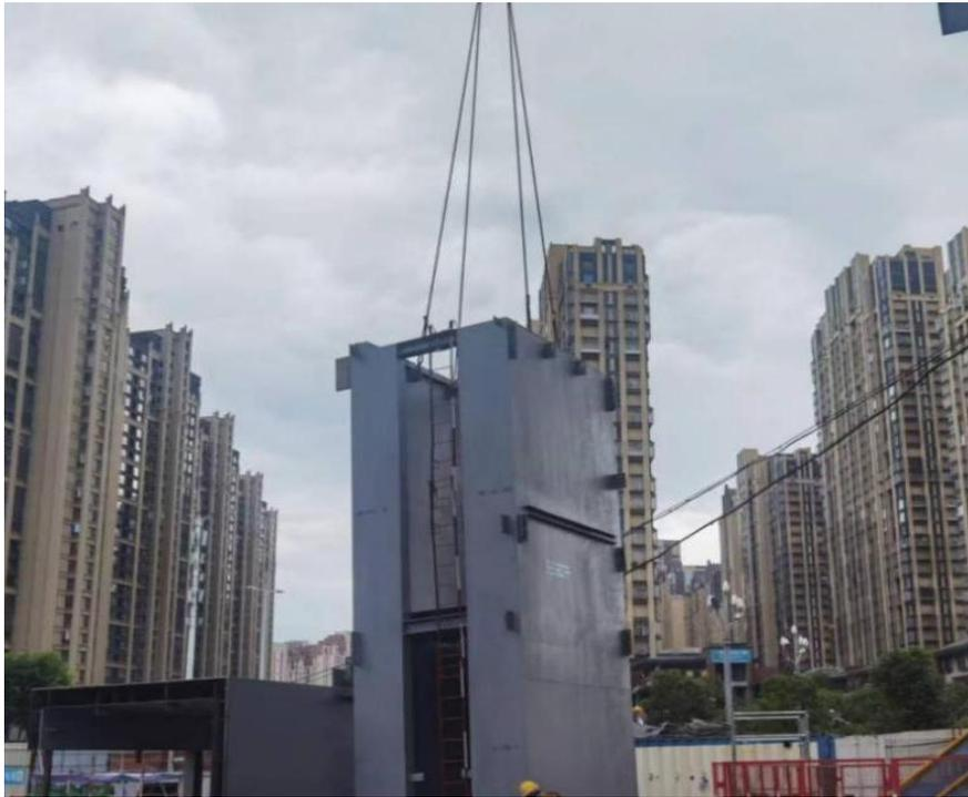
图 6 钢板剪力墙整体吊装
