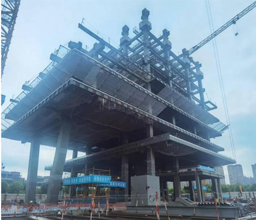
图 7 全装配（少墙）钢框架体系现场快速安装
