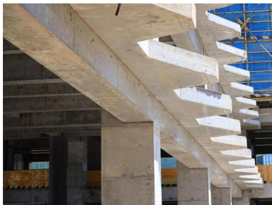
图 25 外挂墙板的挂点结构
