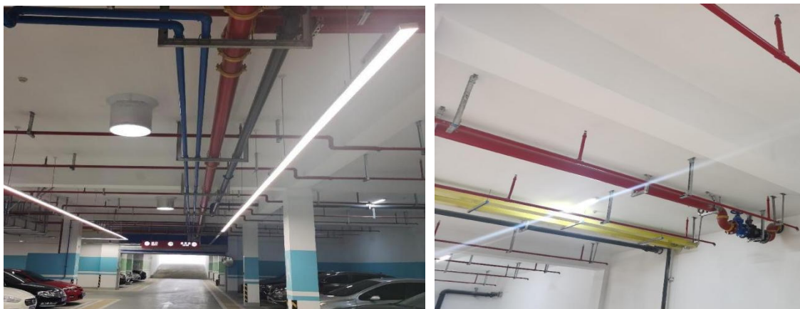
图 20 工业化成品支吊架应用
