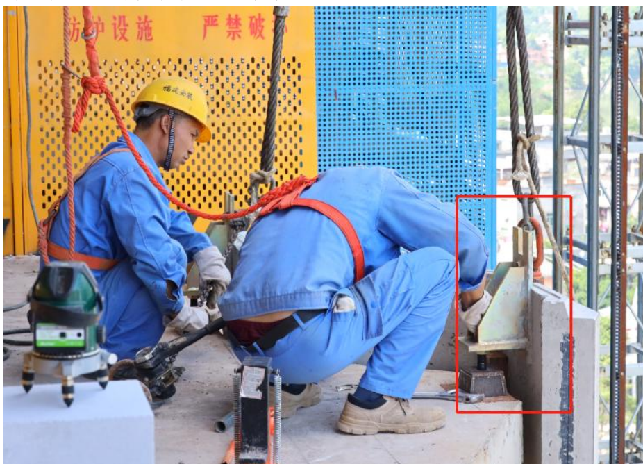
图 29 点支承连接现场施工
