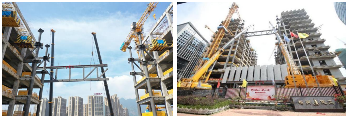
图 9 钢结构连廊吊装施工
