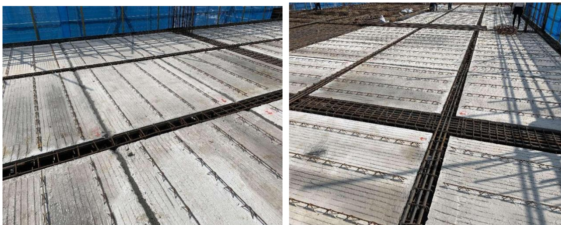
图 19 混凝土叠合楼板施工
