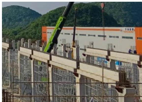
预制混凝土 T 型叠合主梁
