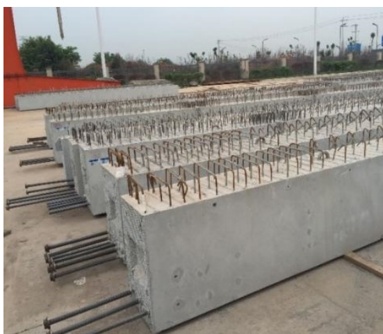
预制混凝土矩形叠合次梁
