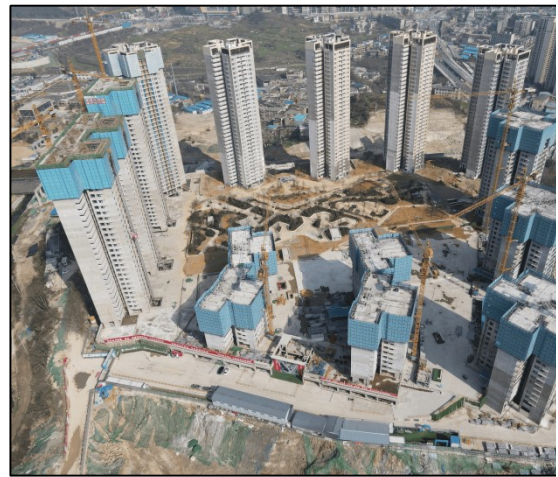
图 2 项目施工现场图
