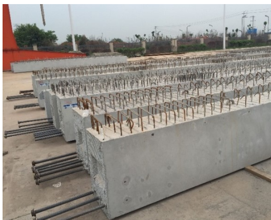
预制混凝土叠合梁
