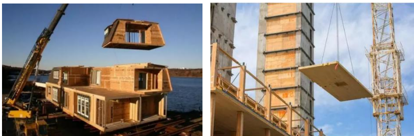
图 12.4.2 装配式木结构建筑吊装
