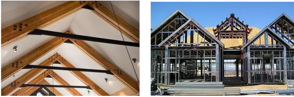
图 2.3 装配式木混合结构
