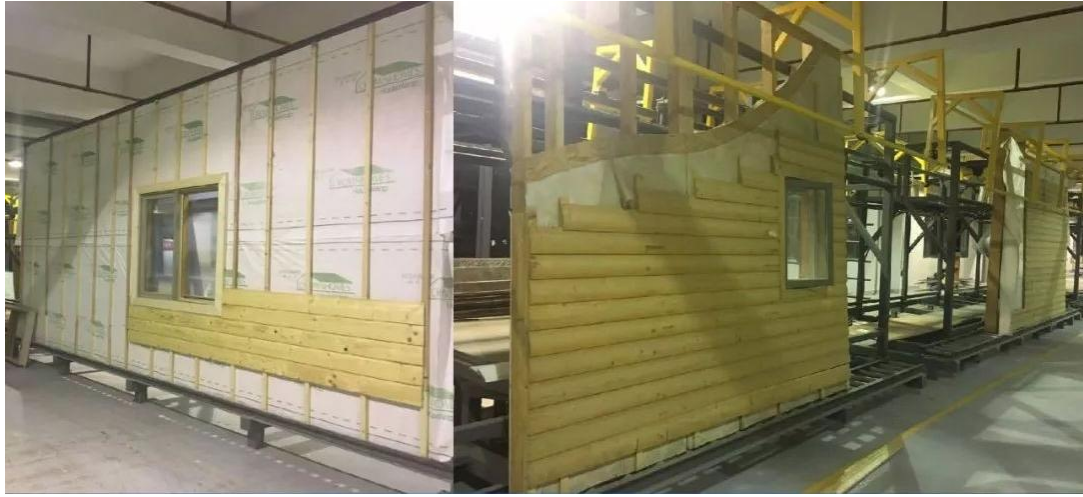
图 6.3.6 预制木骨架组合墙体
