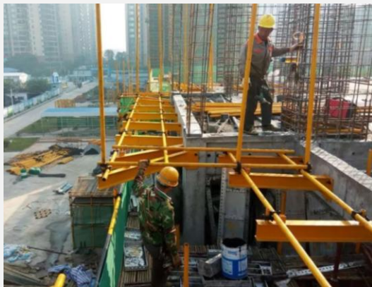
悬臂梁，锚固梁侧
