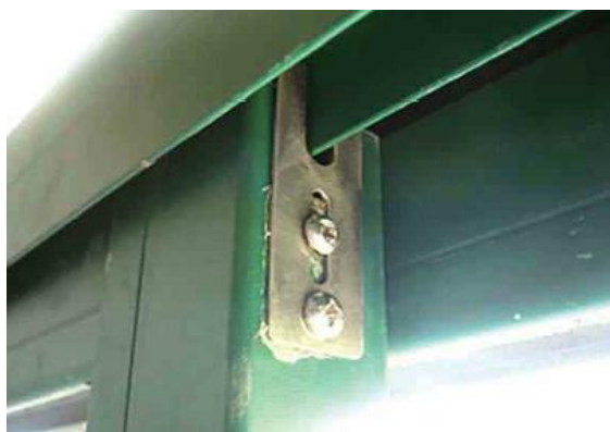
图 2.3-1c 推拉扇防脱落装置片示意照片
