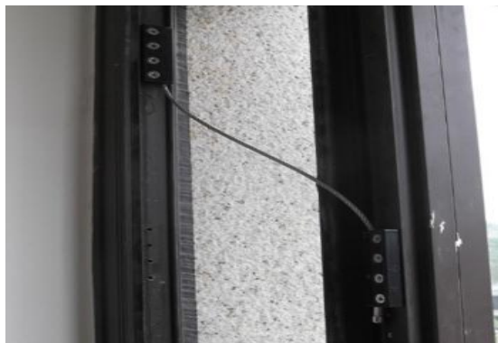
图 2.3-1b 平开扇防脱落示意照片
