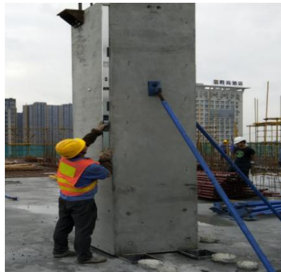
图 7.4.5 使用斜撑调整柱子垂直度
