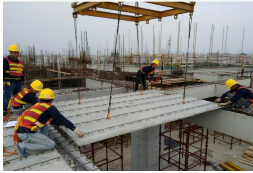
图 7.1.7-1 大尺寸预制楼板采用分配桁架进行吊装
