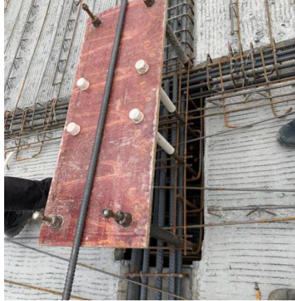
图 7.5.1 露出钢筋定位保护措施
