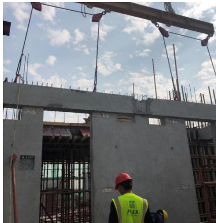
图 7.1.7-2 大尺寸预制梁墙一体构件采用分配梁进行吊装
