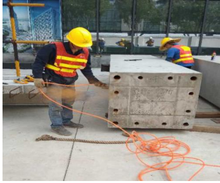
图 7.2.6 预埋螺栓孔清洁图
