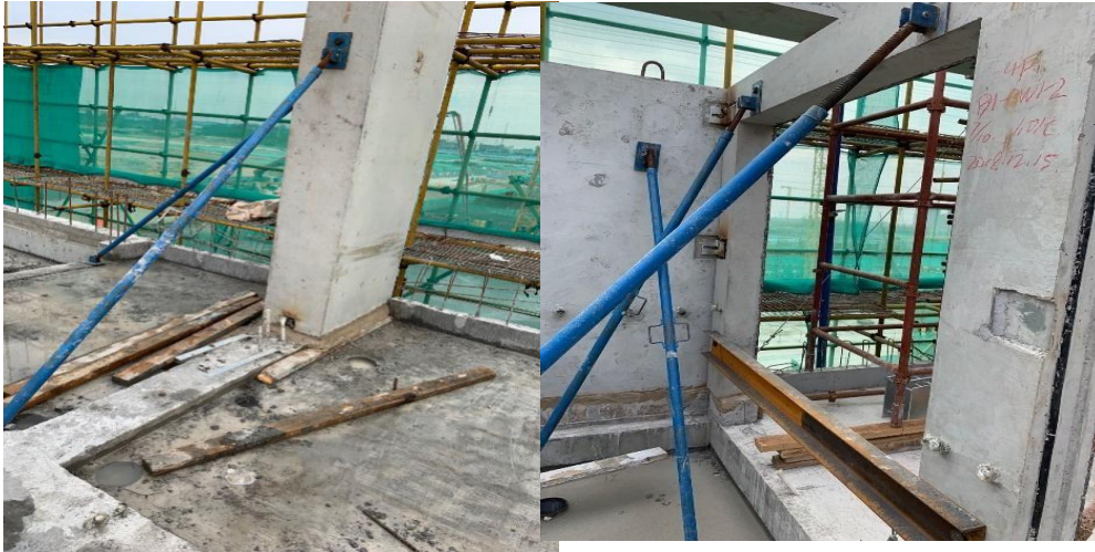
图 7.3.3 构件吊装完成后应马上在两个方向采取临时支撑措施进行固定
