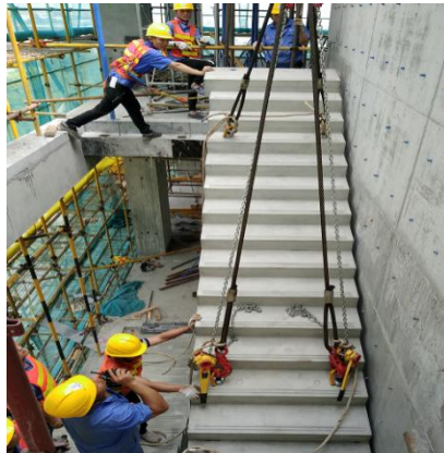
图 7.1.7-3 大尺寸预制楼梯采用分配桁架以及手拉葫芦进行吊装
