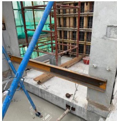
图 7.1.7-3 大尺寸预制楼梯采用分配桁架以及手拉葫芦进行吊装
