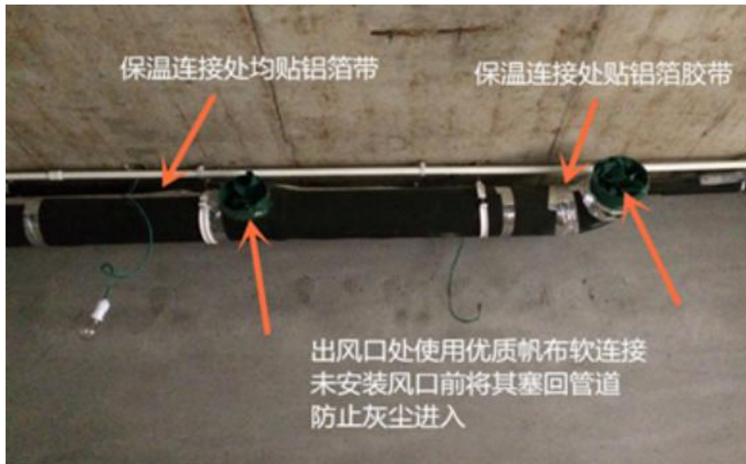
风管节点处理及外墙安装工艺
