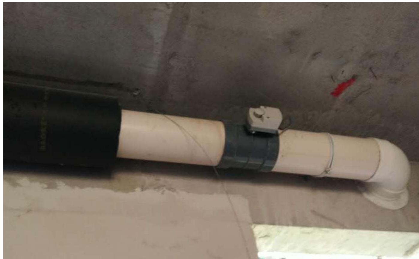
PVC风管与电动气密阀连接及保温
